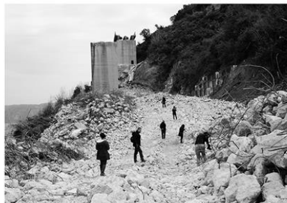
1_demolizione viadotto Costa Viola
