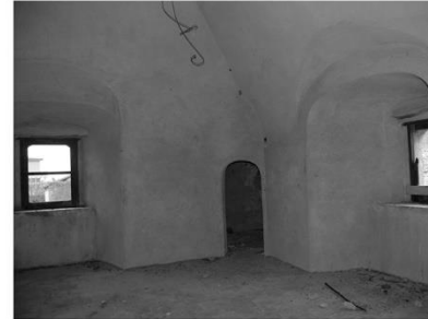
2_ Interno Torre Galea
