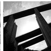
5_fase di demolizione
