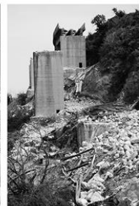
2_piloni viadotto Costa Viola
